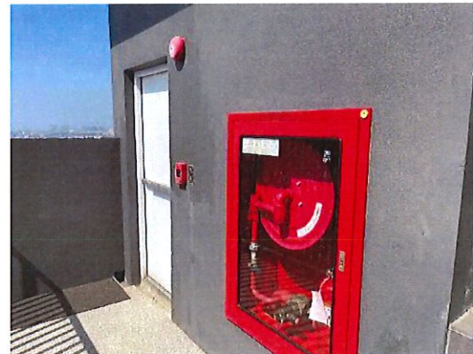
รูปที่ 46 (ต่อ) ตู้เก็บสายฉีดน้ำดับเพลิงพร้อมอุปกรณ์ (Fire Hose Cabinet: FHC)
