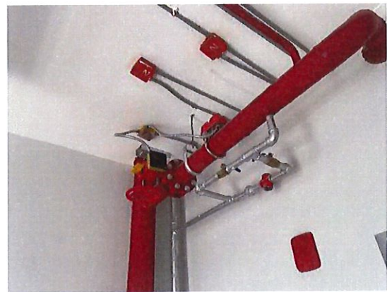
รูปที่ 44 ระบบท่อเย็น (Stand Pipe)
