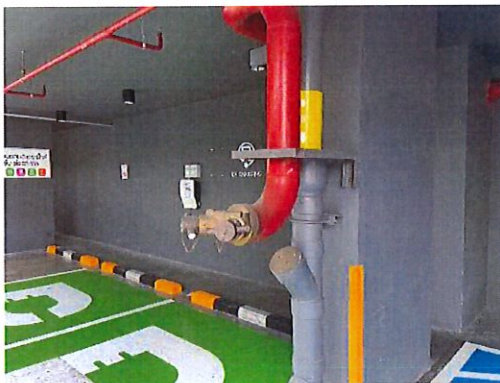
รูปที่ 45 หัวรับน้ำดับเพลิงภายนอกอาคาร (Fire Department Connector)
