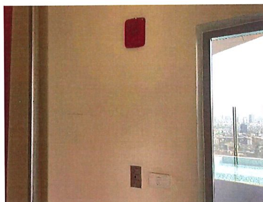
รูปที่ 54 โทรแจ้งเหตุฉุกเฉินเพลิงไหม้ (Telephone Jack)
