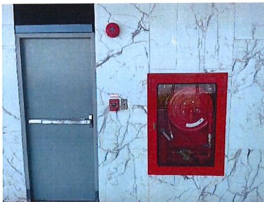
รูปที่ 53 เครื่องแจ้งเหตุโดยใช้มือดึง (Fire Alarm Manual Station)
