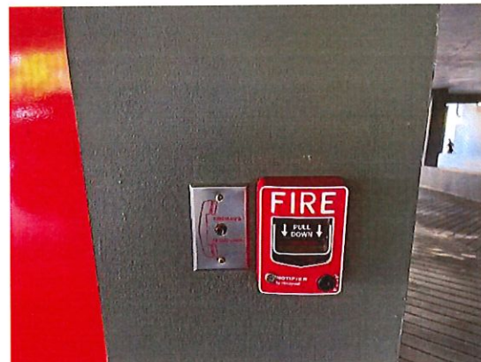
รูปที่ 53 เครื่องแจ้งเหตุโดยใช้มือดึง (Fire Alarm Manual Station)
