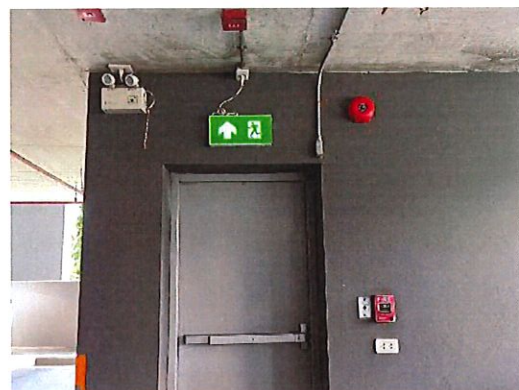
รูปที่ 39 ไฟฟ้าส่องสว่างฉุกเฉิน (Emergency Light)
