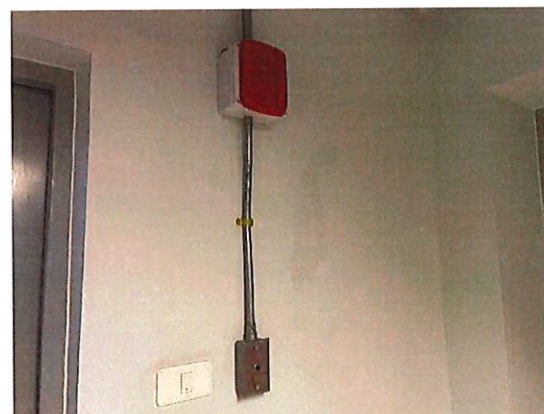
รูปที่ 53 เครื่องแจ้งเหตุโดยใช้มือดึง (Fire Alarm Manual Station)
