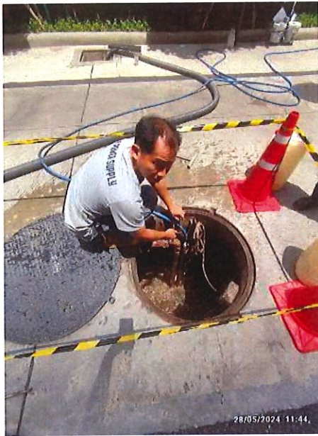
รูปที่ 69 เจ้าหน้าที่ดูดกากและตะกอนส่วนเกินของถังบำบัดน้ำเสีย
