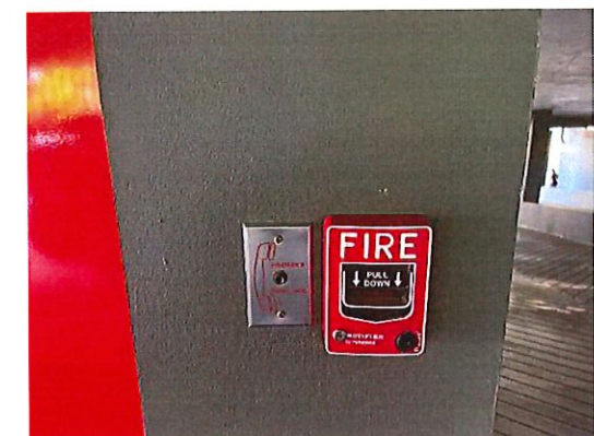
รูปที่ 54 โทรแจ้งเหตุฉุกเฉินเพลิงไหม้ (Telephone Jack)
