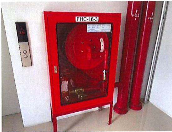
รูปที่ 44 ระบบท่อเย็น (Stand Pipe)
