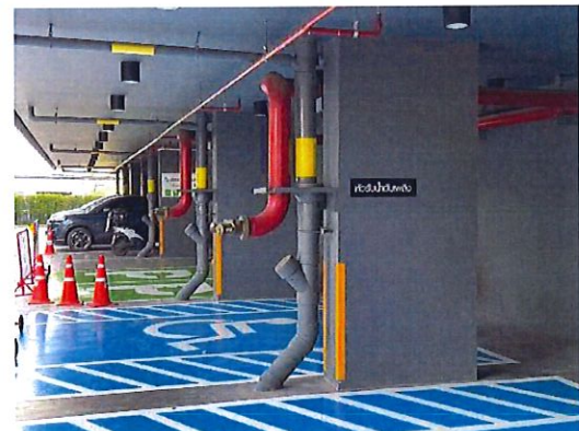
รูปที่ 45 หัวรับน้ำดับเพลิงภายนอกอาคาร (Fire Department Connector)
