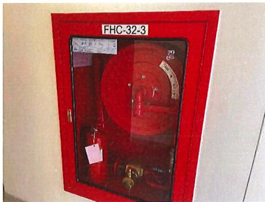
รูปที่ 46 (ต่อ) ตู้เก็บสายฉีดน้ำดับเพลิงพร้อมอุปกรณ์ (Fire Hose Cabinet: FHC)
