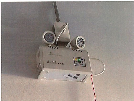
รูปที่ 39 ไฟฟ้าส่องสว่างฉุกเฉิน (Emergency Light)
